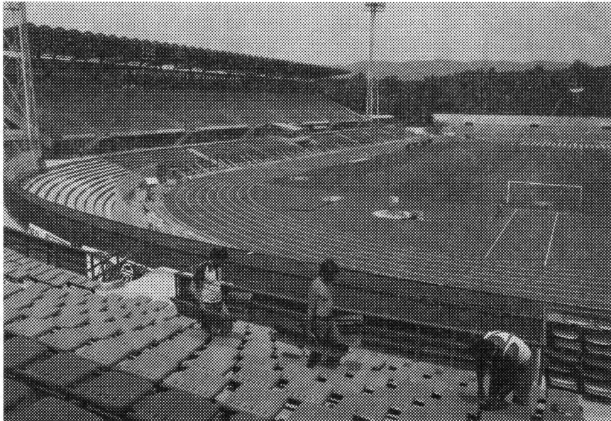
Montaža na stadionu Dinamo za Univerzijadu 87
